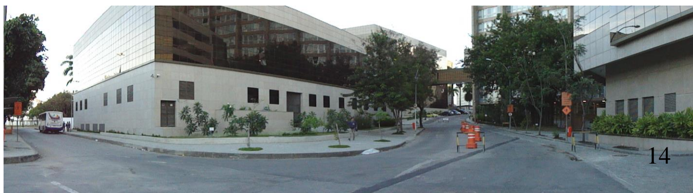
Foto 14 – Edifício Lâmina III
