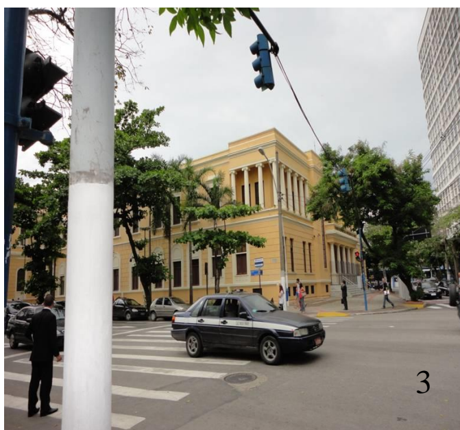
Foto 3 - À esquerda, fachada da lateral e dos fundos do Palácio da Justiça. E, à direita, parcial da fachada frontal do Edifício das Secretarias. Vistas vista do cruzamento da Rua Visconde de Sepetiba com Avenida Ernani do Amaral Peixoto
